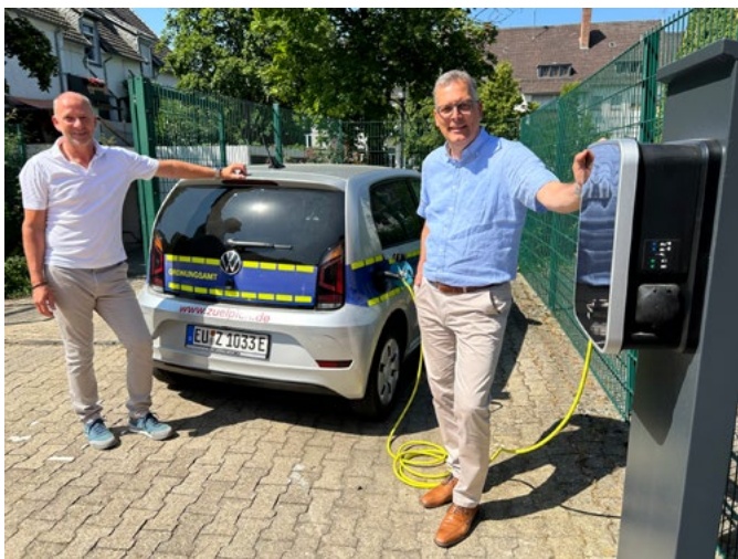
Das Foto zeigt Bürgermeister Ulf Hürtgen (r.) und Westenergie-Kommunalmanager Achim Diewald an einer der vier Wallboxen im Bereich des Rathauses, an denen künftig die städtischen Elektrofahrzeuge geladen werden können.
